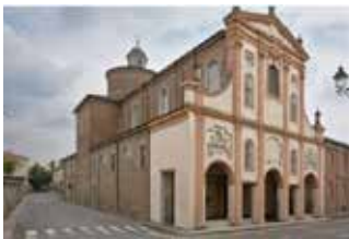
RESTAURO DEL SANTUARIO DELLA BEATA VERGINE DELLA PORTA IN GUASTALLA
